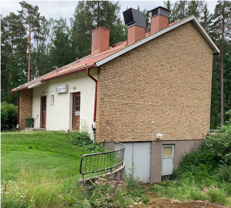
Figur 8, Fasadbild från nordväst
