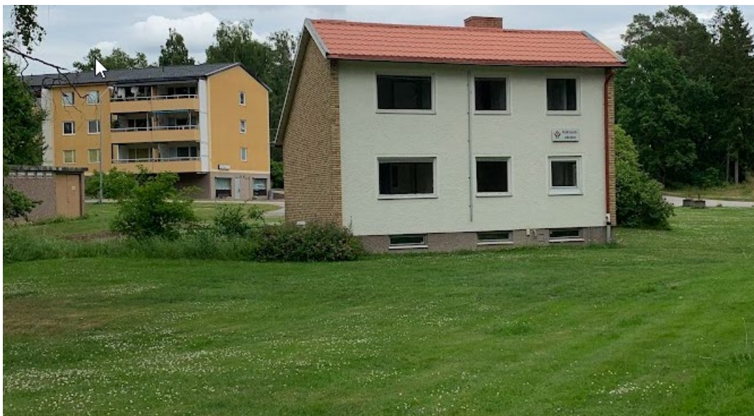
Figur 6 Byggnadens fasad mot Jägargatan
