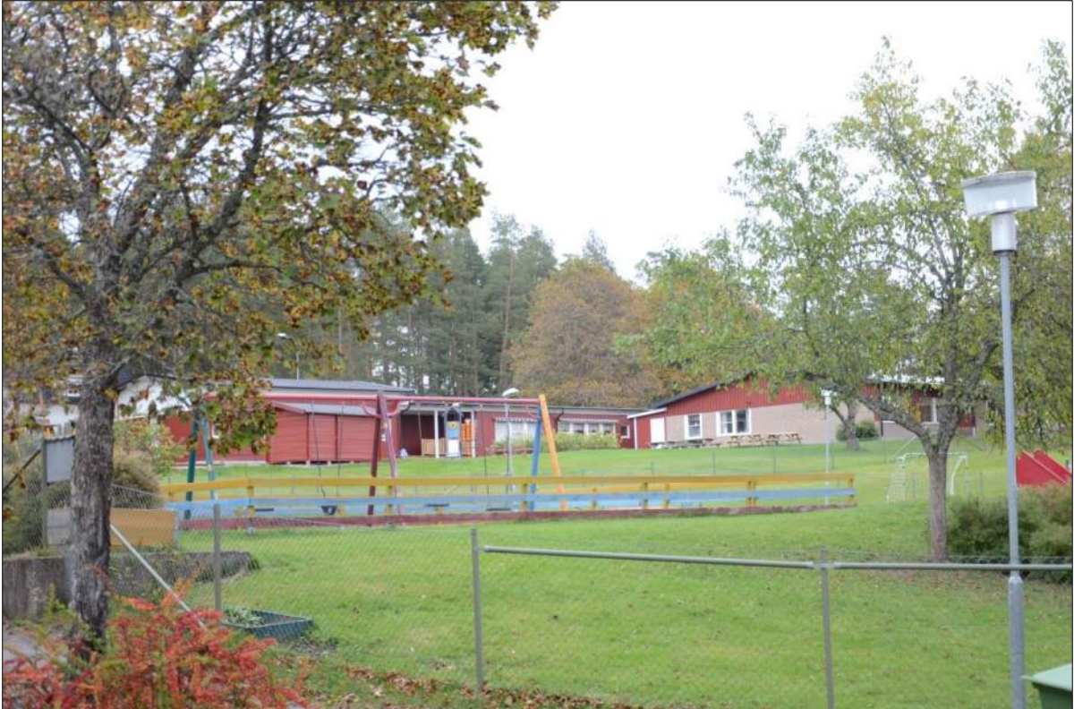
Förskolan sedd från sydväst.
