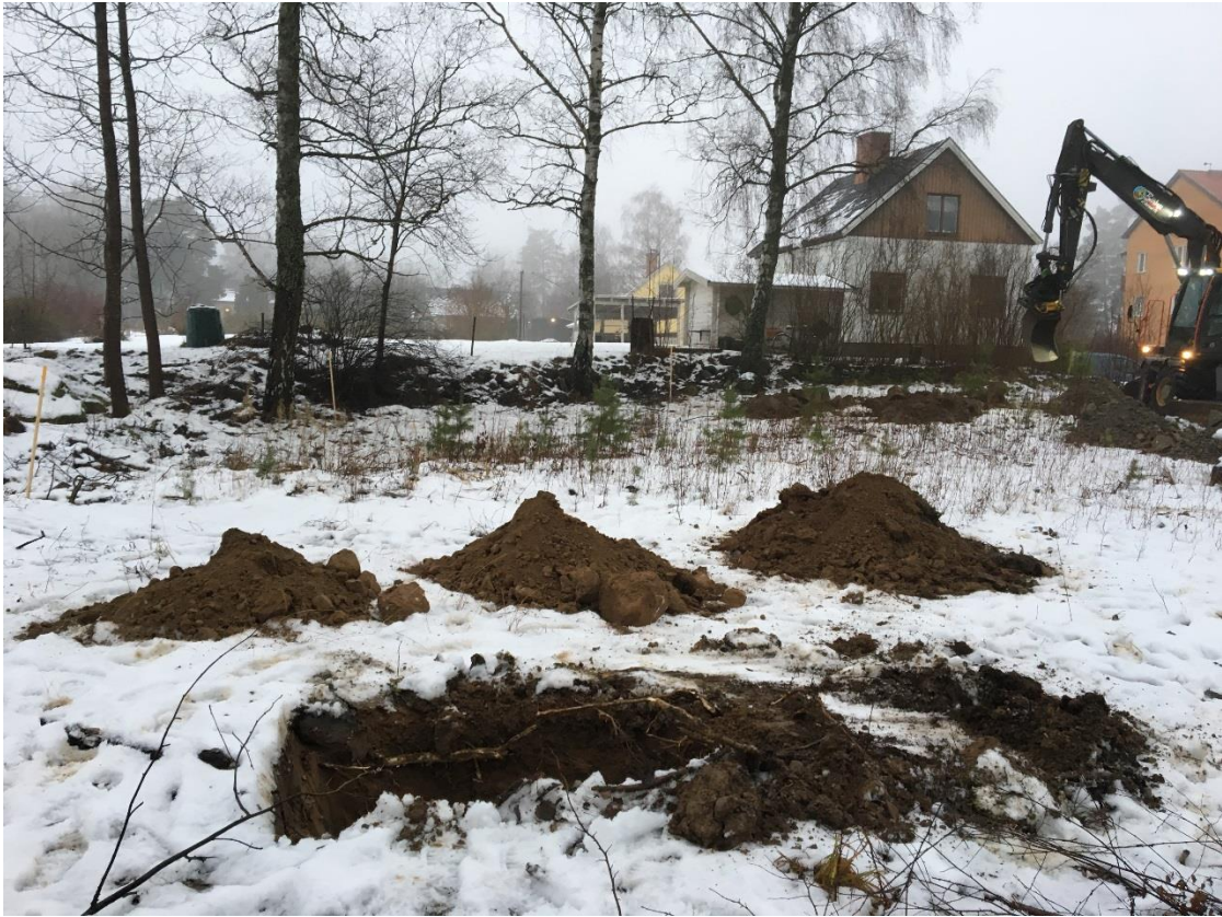
Figur 9. Bild på provgrop SW17_07. I bakgrunden ser vi byggnaden på Dalavägen 28
