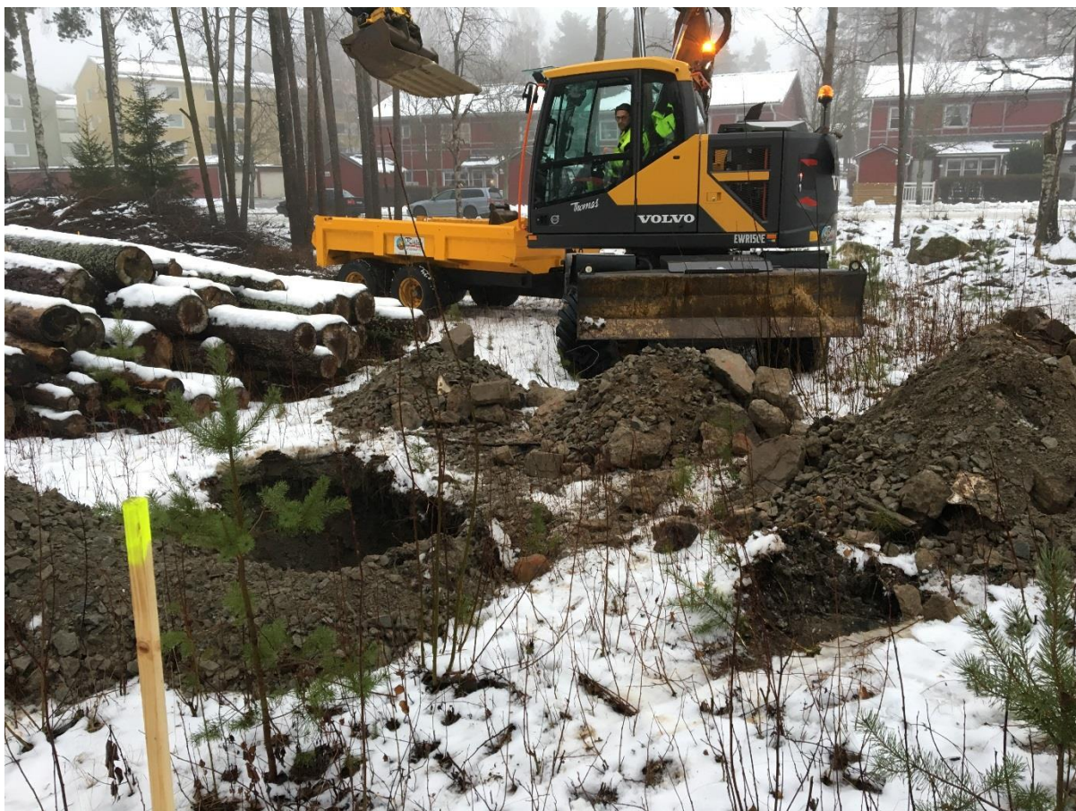
Figur 10. Bild på provgröp SW17_01. I bakgrunden går Källbergsvägen
