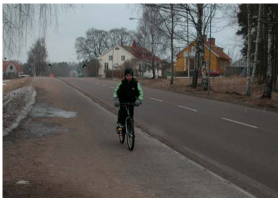
Vid Släggärvägen upphör gång- och cykelbanan.
