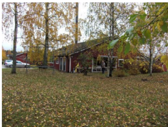
Tilltänkt byggnadsplats, servicebyggnaden sedd från väster.
